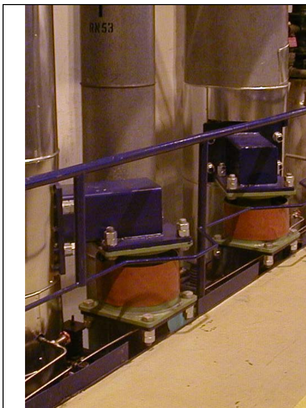
Рис. 2. Установка демпфера ВД на вертикальном участке трубопровода
