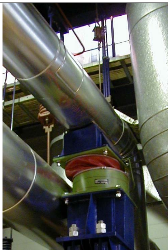
Рис. 3. Установка демпфера ВД на горизонтальном участке трубопровода
